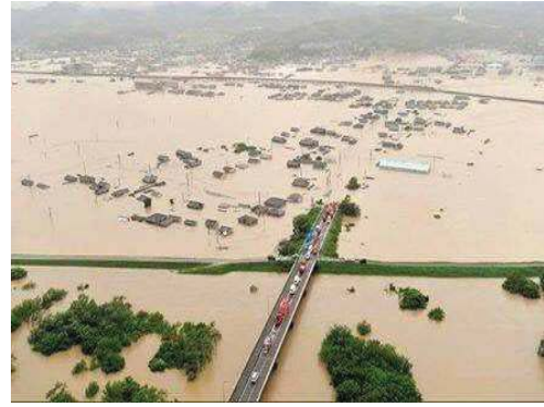
西日本豪雨による浸水被害
