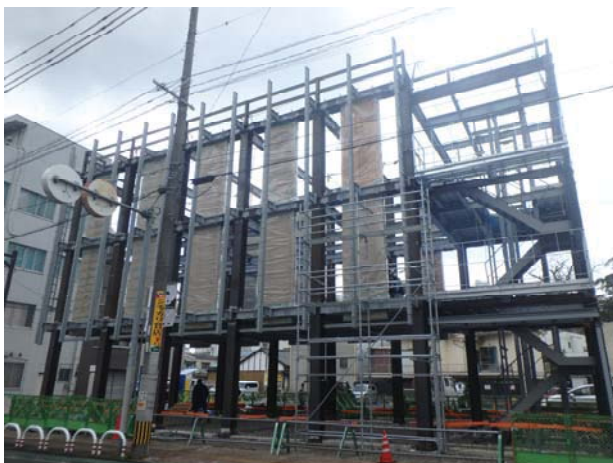
写真 2 現場施工状況 (CLT 壁パネル)
