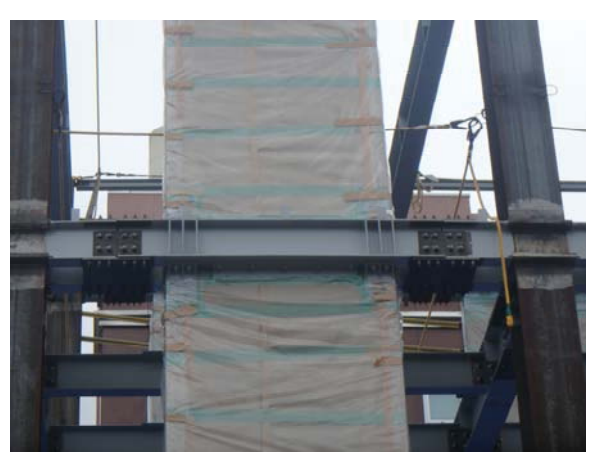
写真 2 現場施工状況 (CLT 壁パネル)
