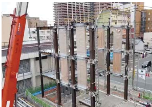
(Fig3:建方写真)
