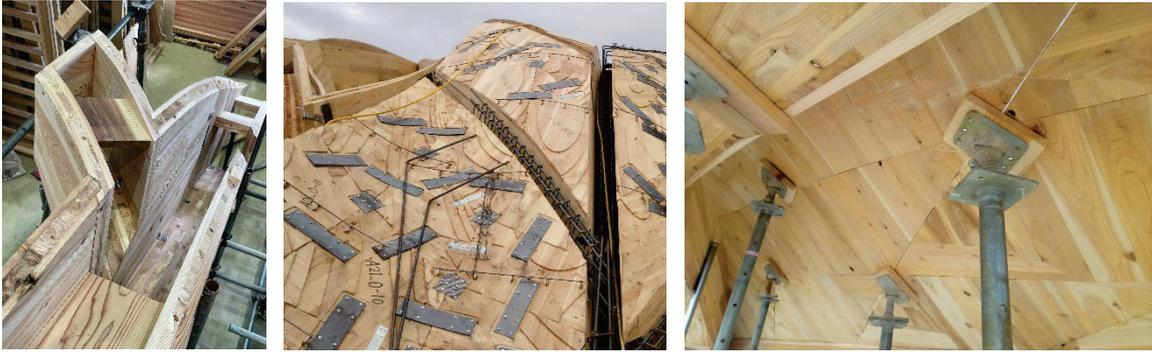
次に、梁の幅が小さく、成が大きいいため、型枠の組み立てと鉄筋の配筋の施工手順に協議を重ねた。当初、鉄筋を梁に落とし込むことが難しいため、大梁・小梁共梁側面の型枠を開放しL字で梁型枠を組み、梁鉄筋を配筋後、開放側の側面型枠を塞ぐ方針で組み上げる方針で施工を行うことを検討していた。しかし、小梁に関しては、大梁の接合部に垂直に落とし込んでいくため、梁側面型枠と梁底型枠の接合部形状上、片側の側面型枠を開放した状態で落とし込むのが難しく、最終的にはコノ字型に組んだ小梁型枠を大梁間に落とし込む施工手順となった。型枠が組み上がった列から現場の原寸場で配筋した梁鉄筋をクレーンで吊り、大梁→小梁の順で型枠に落とし込み、配筋完了後、開放されていた大梁側面型枠のはめ込むという流れで施工を行った。落とし込んだ鉄筋は大幅な修正ができないため、細心の注意を払う施工が行われた。
