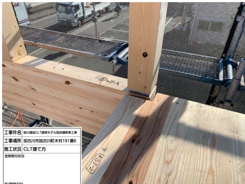
CLT 組付け連結金物を固定
