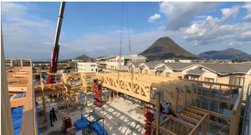
▲トラス吊り込み
