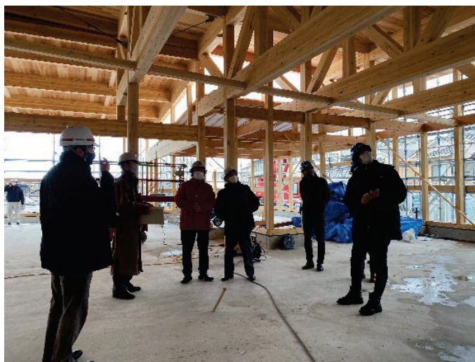
◀建て方完了後の内部の様子
