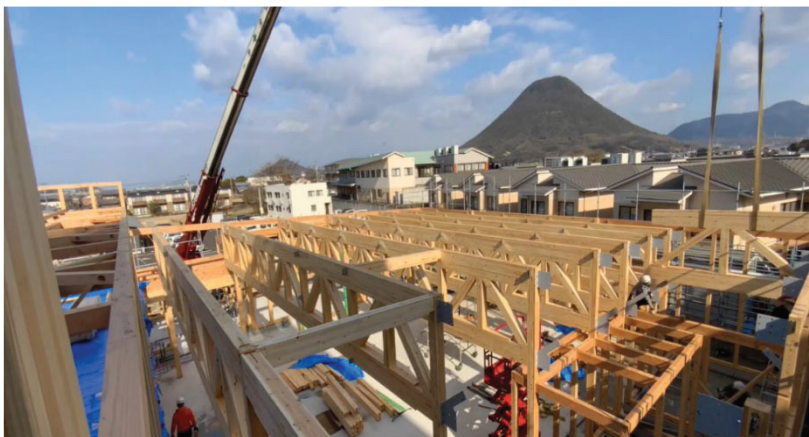
▲トラス吊り込み
