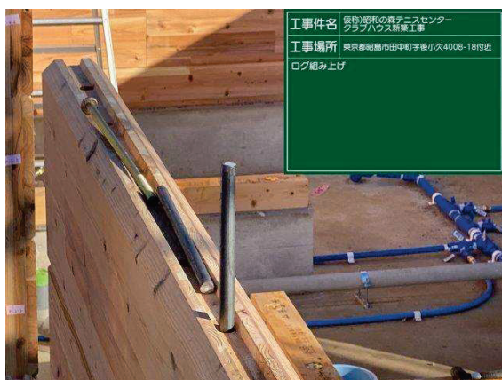
写真 4-5 ダボ施工時の様子
