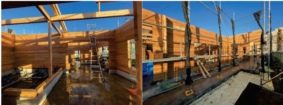
写真 4-6 CLT ログ壁の施工完了
