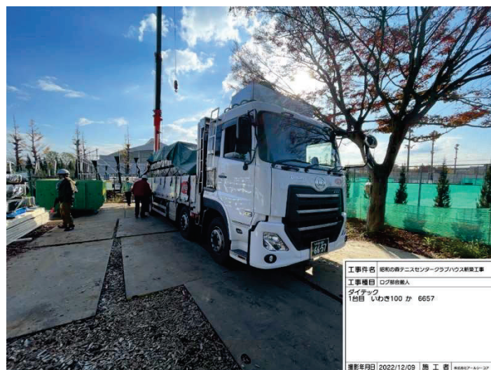
写真 4-1 資材搬入状況
