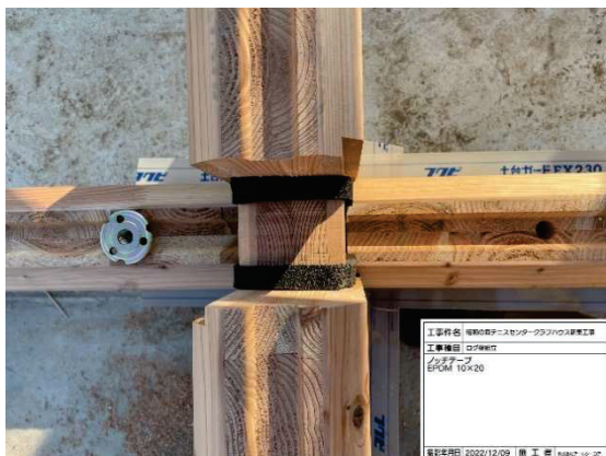
写真 4-3 ノッチ部の精度が高く隙間がない
