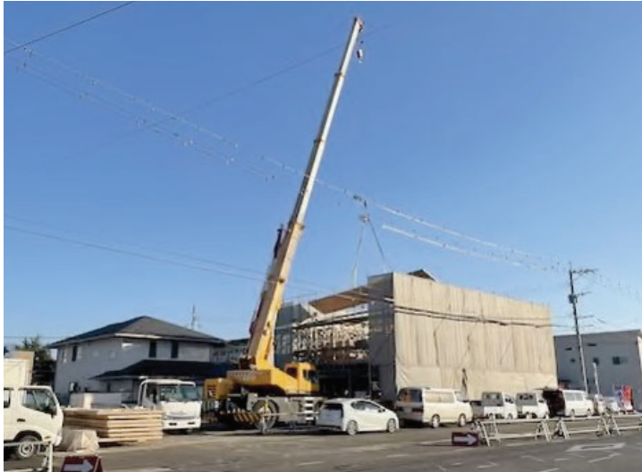
○ CLT折版屋根の建方の様子
