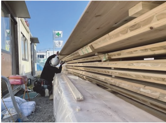
○ パネリド接合部は予め地上で下穴を開けている
