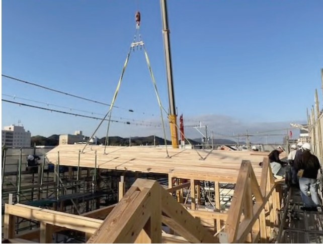
金物を取り付け、4点で支持をしてクレーンで吊り上げる
