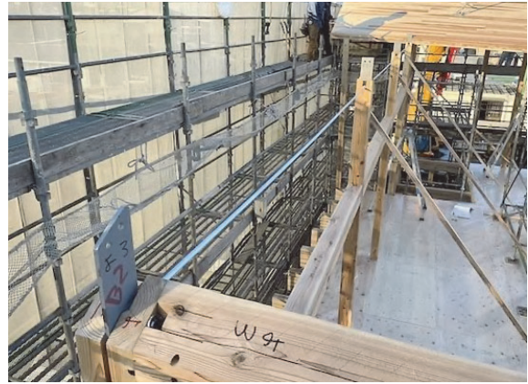
○CLT固定のための柱頭金物と開き留めのタイロッド
