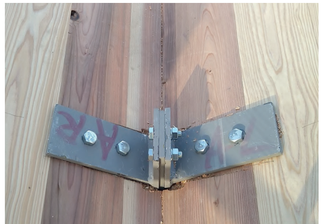
CLT折版屋根と柱頭金物を固定する金物
