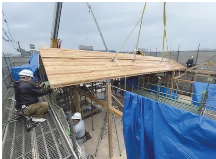
○ X2-X5の壁が無い範囲は、山部にCLT折版屋根の位置の調整を行った
