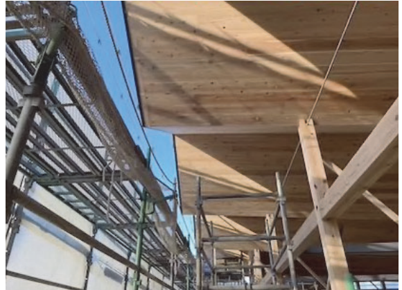
○軒先は、CLTのカットピースを取り付けることで将来取り替えが可能な納まりとした
