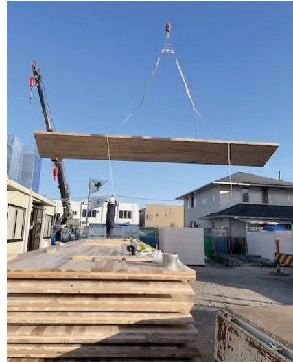
○ 施工順にCLTを重ねている
