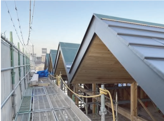
○軒先は、CLTのカットピースを取り付けることで将来取り替えが可能な納まりとした
