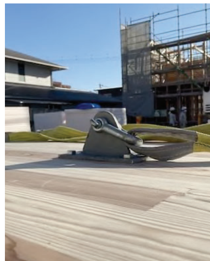
○ 吊り金物を取り付け4点で支持をし、25tクレーンで吊り上げCLTの建方を行った
