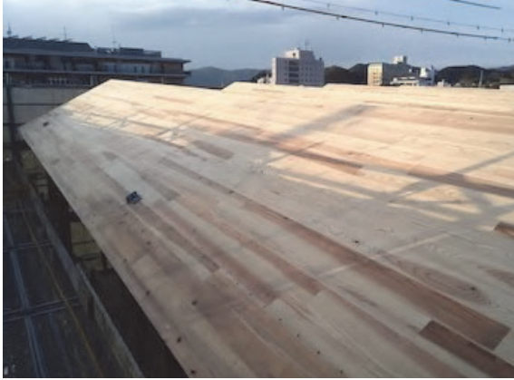
○CLT折版屋根の施工完了時
