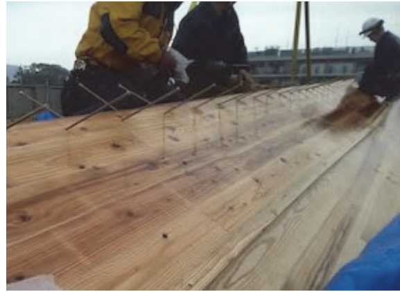
○ CLT同士をパネリドで接合する様子
