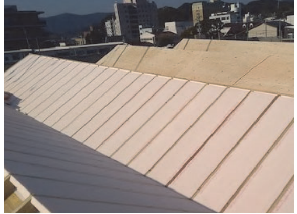
○断熱t90のスタイロフォーム材敷き込みの様子
