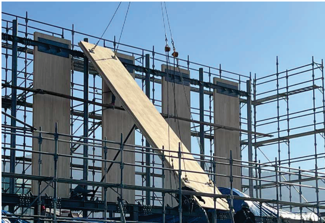
鉄骨会社による CLT+鉄骨総合建方 Fig.6.
