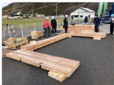
高耐力CCU組立1 (長辺側の門型組立)
