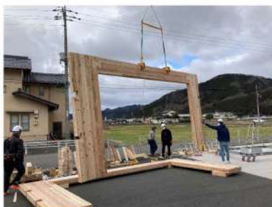
高耐力CCU組立2 (門型吊り上げ)
