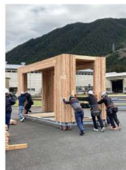
高耐力CCU組立6 (ユニット完成)
