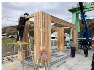
高耐力CCU組立4 (短辺側繋ぎ)
