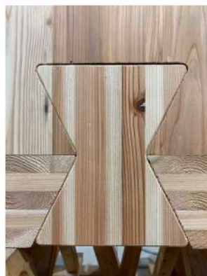
高耐力CCU 蝶蟻結合 (SAI開発/ミヨシ加工) R8
