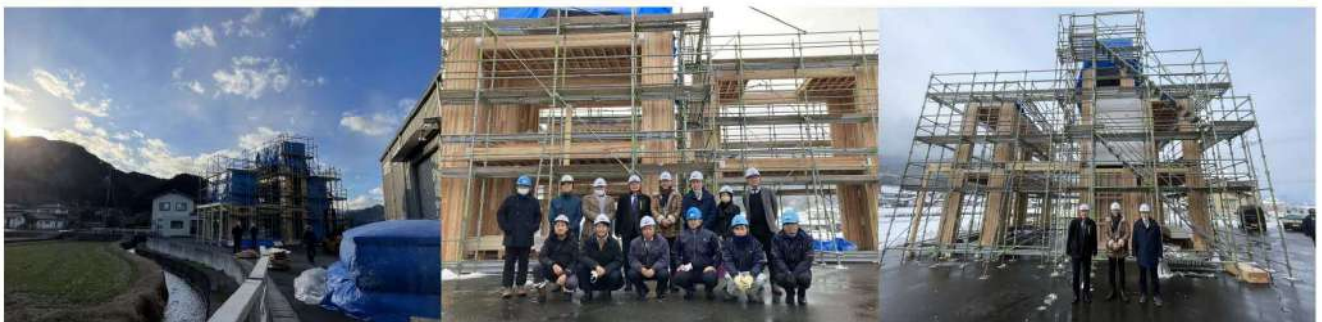
3層施工実験モデル棟4 （全景）
