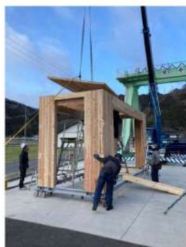
高耐力CCU組立5 (天井版設置)
