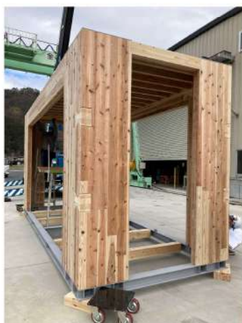
高耐力CCU (天井版取付)
