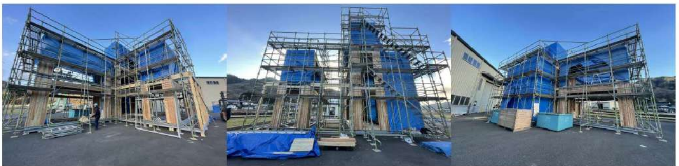
3層施工実験モデル棟1 （北東面）
