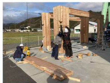
高耐力CCU組立3 (門型設置)
