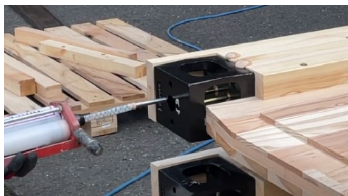
図10 接着剤の充填工程
