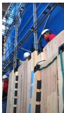
図 1 7 柱頭へのボルト取り付け
