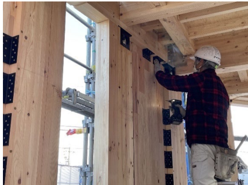
図21 L字金物での耐力壁と梁の固定工程
