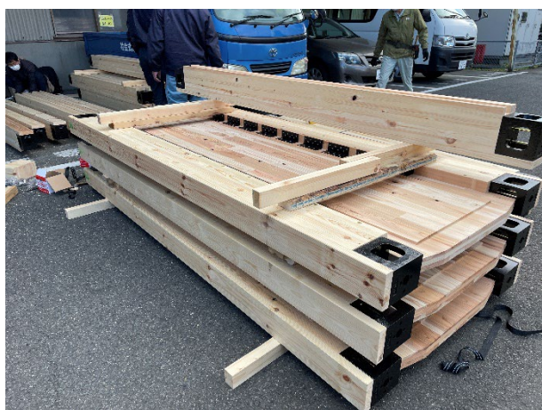
図11 接着剤養生中の耐力壁パネル
