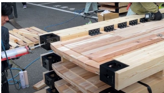
図9 柱頭・柱脚金物とパネルとの接合工程
