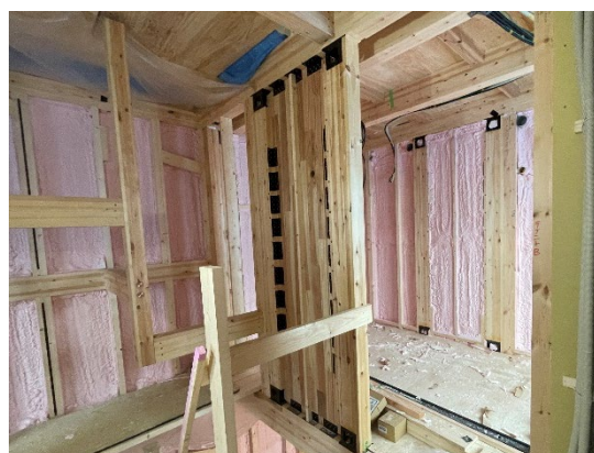
図 2 6 耐力壁の裏面
