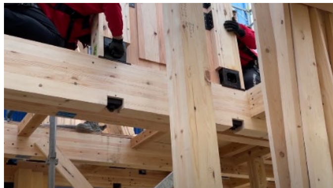
図20 上階での耐力壁固定
