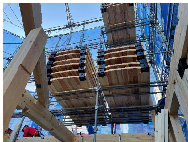
図12 現場で荷下ろし直後のパネル
