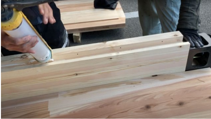
図5 柱への接着剤塗布工程
