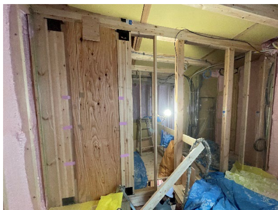
図 2 5 耐力壁の表面（内装現し側）
