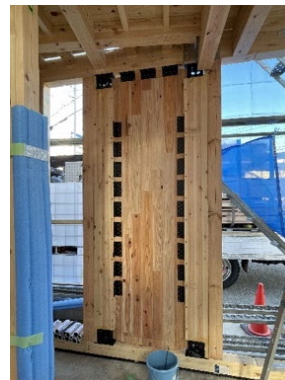
図22 工場施工型 CLT 耐力壁 設置完了写真
