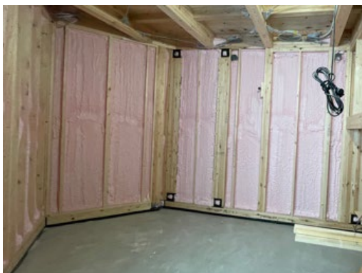
図 2 3 断熱際の吹き付け後
