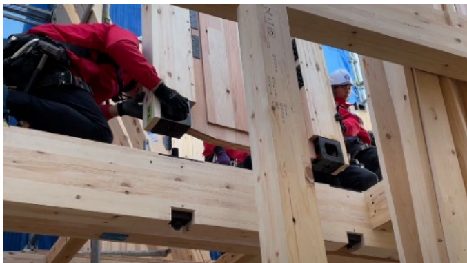
図19 上階での耐力壁配置
