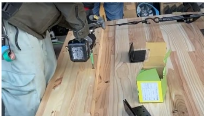
図7 柱と CLT のビス接合工程
