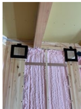
図 2 4 柱頭・柱脚金物の断熱処理
