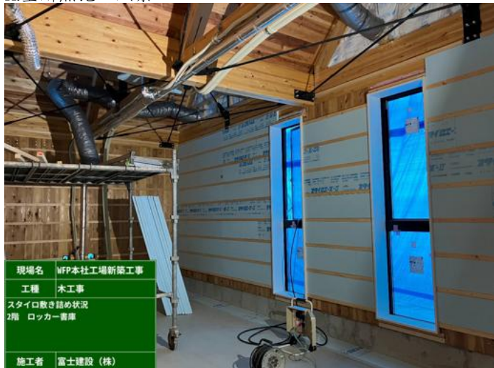
h.壁断熱施工風景
