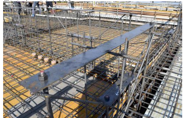
d.アンカーセット状況
