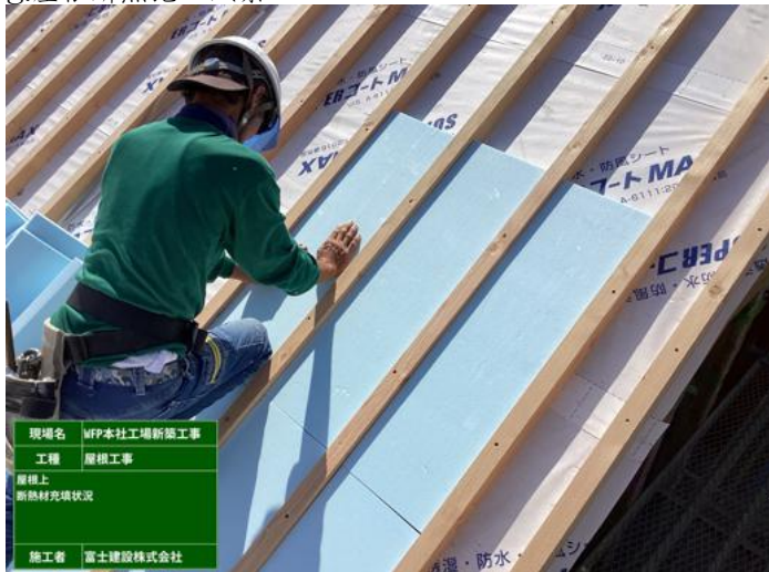
g.屋根断熱施工風景
