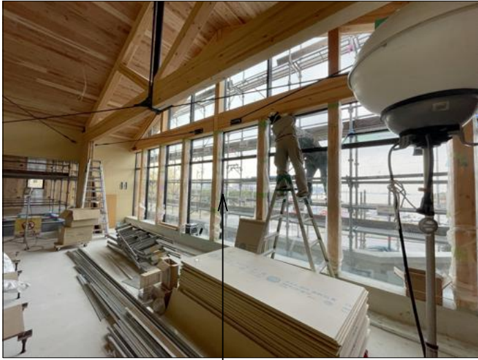
構造躯体の柱梁に方立てを隠している
