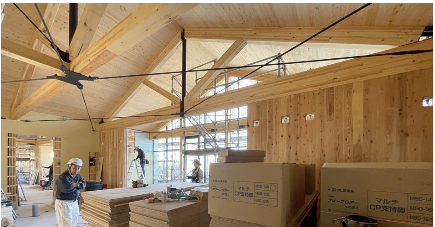
z.香川県産ヒノキを使用したホールのトラスとCLT
