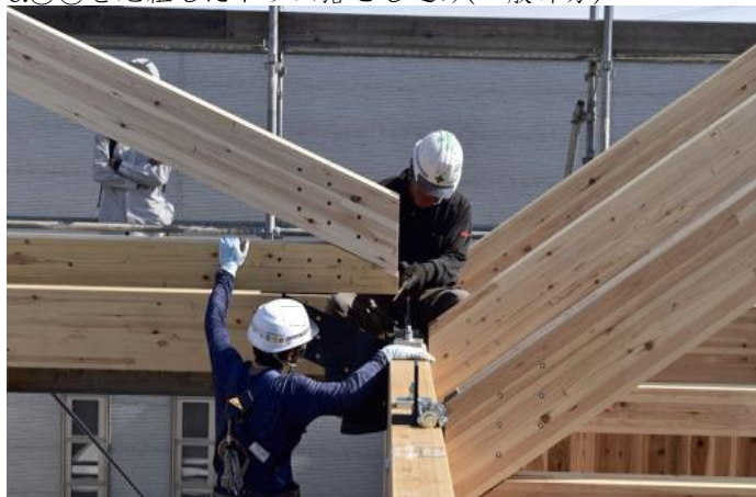
c.①②を地組したトラス落とし込み(一般部分)
