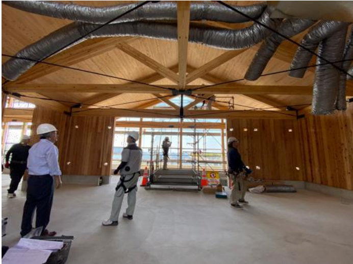
m. 建て方、CLTヒノキHBの確認
