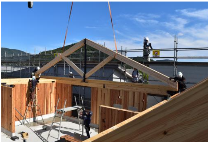
x.2階スラブで地組し、トラスを立て込む
