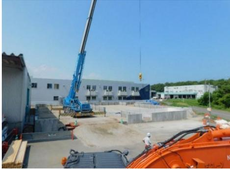
配送センター敷地と基礎工事終了写真 敷地周囲に大型重機作業スペースがないため 倉庫内土間コンクリートは外部工事終了後に 行う事で計画。切り込み砂利転圧で終了。 建物内に大型重機搬入をし、建て方作業を行う。
