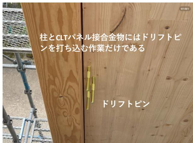
CLTパネル取付作業開始前に協議会委員、現場監理者、設計者、作業員と事前確認作業を行う。CLT耐力壁は両側の柱に設置済み金物にドリフトピンで固定されるが、柱とパネル間の隙間が標準1mm～2mm以下に設置されるかを実際に施工確認を地上で実証確認作業を行った結果、目標値内で締め付け可能であることを確認後、実施施工を開始した。
