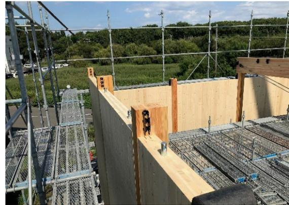
柱間隔2550@にスパン15.3mの張弦トラスが柱上部に掛かり、梁間方向を繋いでいる。右側写真CLTの上には150×240の桁が柱間を繋ぐ。パネル上部にせん断キーが見えるこのせん断キーを吊上げ時に利用している。張弦トラスは地上で組み立てられクレーンで吊り設置する。多雪地域での木造大スパンを可能にしている。
