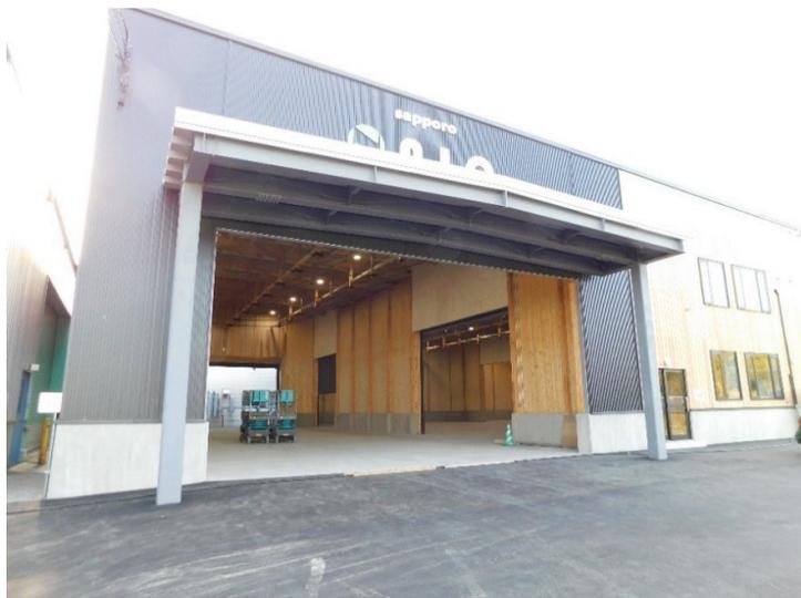
最近のこの地域降雨量1100～1250mmと増えており、建物正面には軒の出2.8mの鉄骨造庇を、別棟構造で設けている。設計時に降雨角度45度を想定しても荷捌きスペース手前床は濡れることを想定し、床勾配での排水としている。重量物積載フォークリフトの通行時振動を避ける為、当初より床段差は設けていない。
