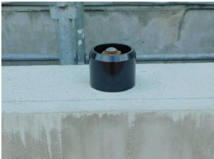
CLT耐力壁用せん断キー径90mm 中央のアンカーボルトM-24 でコンクリートに定着されている CLT耐力壁W2400 中央に1か所だけ設置される。 コンクリート基礎幅は250mm基礎天端はセルフレベルモルタル 施工でCLT面とのレベル確保している CLTパネル設置時には基礎天端に防水コーキング材を充填しパネルを乗せている。倉庫なのでゴム製気密材より安価に施工。
