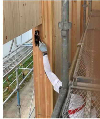
写真黒の金物は(株)ATAの既製品金物で、柱1本に4か所設置をプレカット工場にて取付 CLT小口側には溝加工されている為、梁受金物を通過して降ろされていく。金物通過手前で効果スピードを抑え、多少のずれは写真右側のようにパネルを誘導 写真左下のようにスムーズに通過していく。1枚当たりの施工時間は、地上吊上げ開始から10分程度で進んだ。施工性の良さは確実に実証できた。クレーンオペレーターの技能も左右する。
