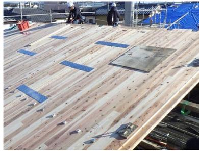
図2 CLT 同士の STW 金物接合の様子
