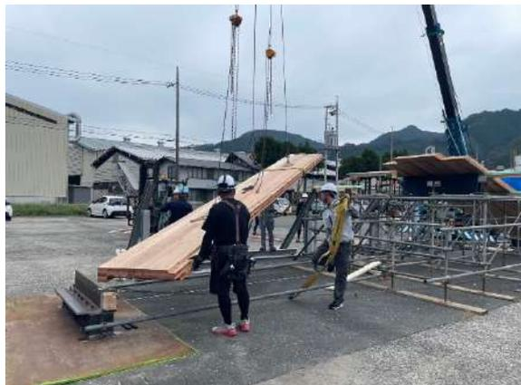
図25 パネル吊り込みの様子
