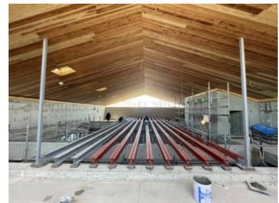
図3 支保工取り外し後の室内写真
