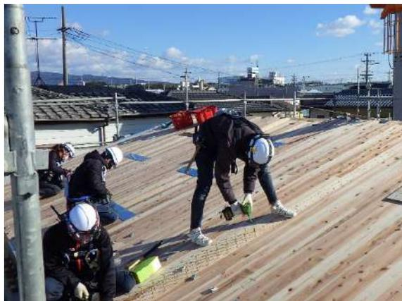
図35 CLT同士のビス接合の様子
