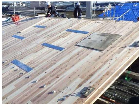
図36 CLT同士のSTF金物接合の様子
