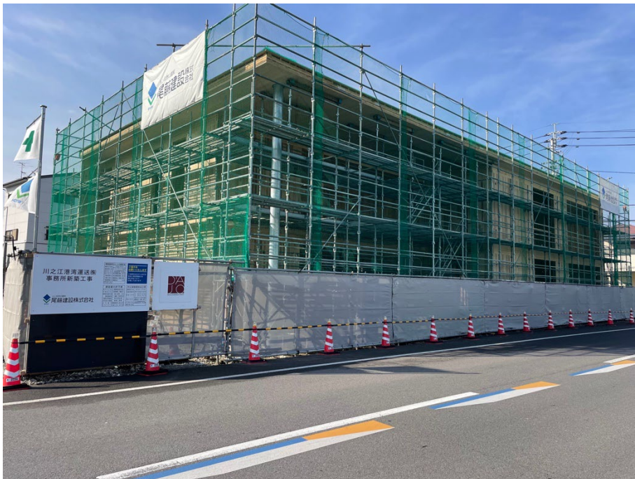
上棟時建物北面より撮影
