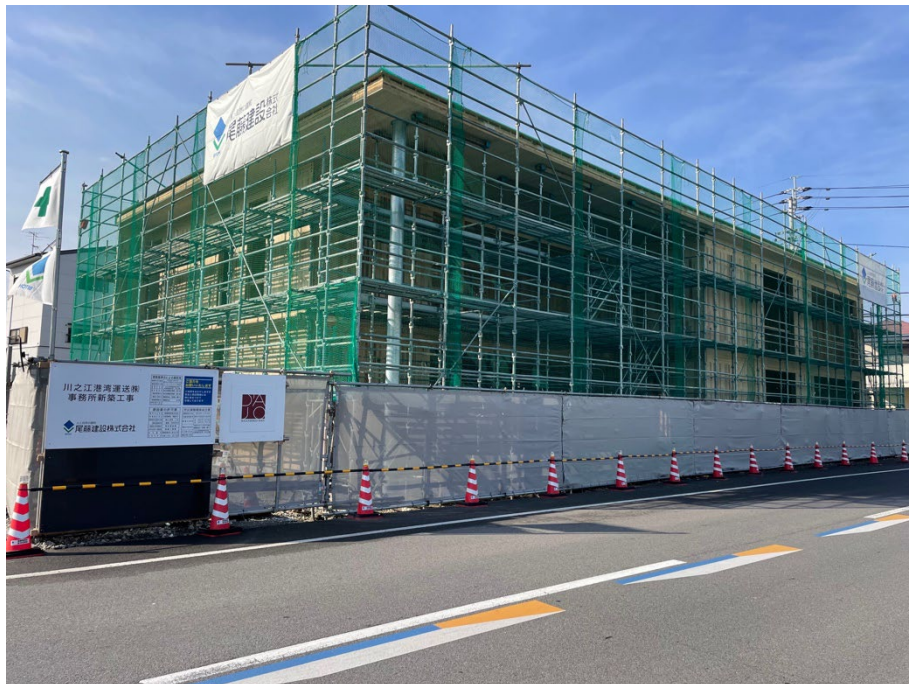
上棟時建物北面より撮影
