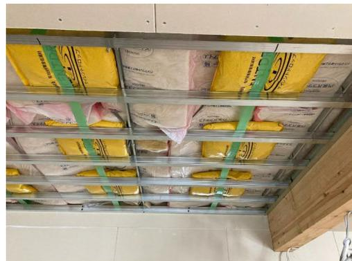
集合住宅において、上階からの音対策は、入居率に大きく影響する。一般に重量衝撃音は、上階からの振動が床→CLT床パネル→釣りボルト→下階の天井と伝わる。粒状床衝撃音低減材は、上階からの振動を天井材に伝わる前に、粒状材の衝突・摩擦により吸収し、音を低減する。
