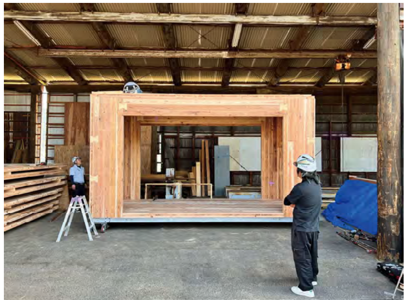
CCU 組立完了
