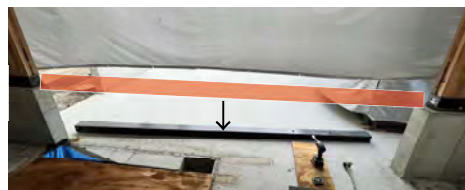
補強鉄骨取り外し後
