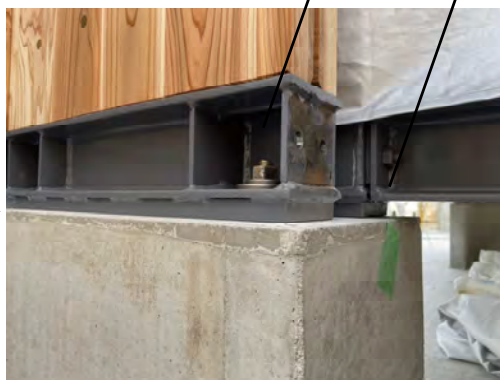
補強鉄骨取付部
