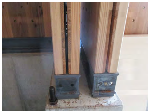
補強鉄骨取り外し後
