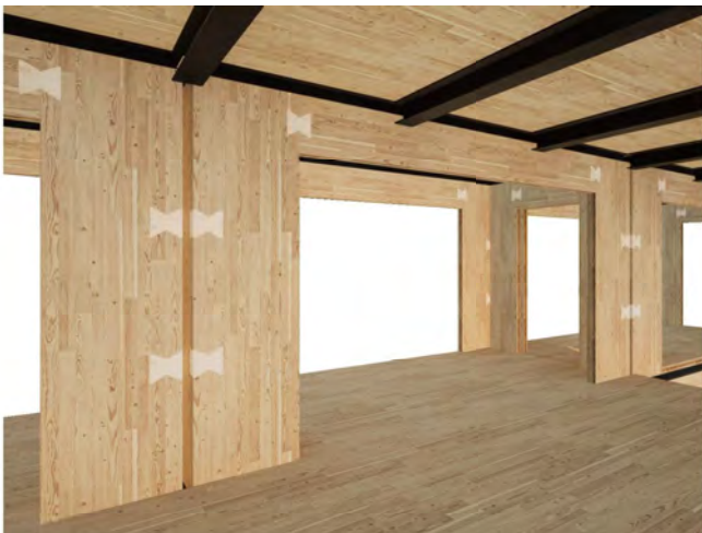
Unit 上部に鉄骨追加
