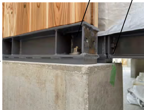
補強鉄骨取付部
