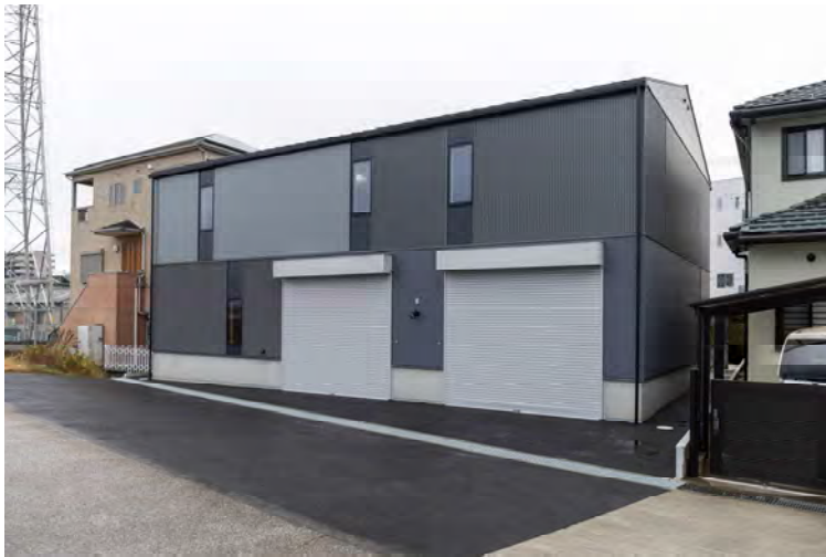
外観ファサード①
