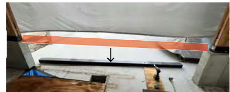
補強鉄骨取り外し後
