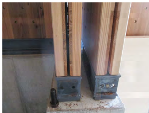
補強鉄骨取り外し後
