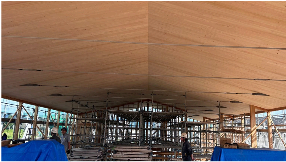
建て方完了時
