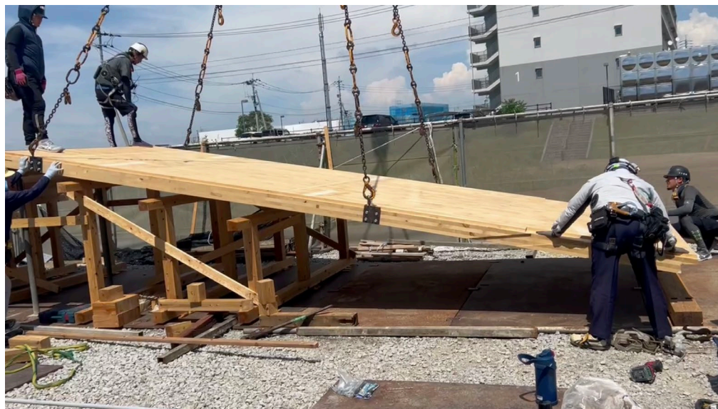
地上での仮組時
