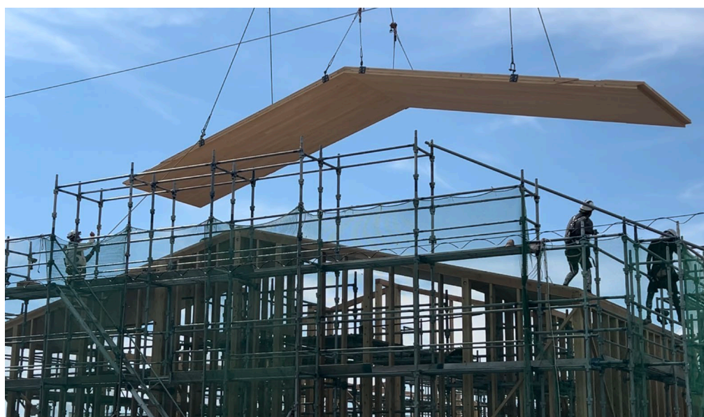
クレーン施工時
