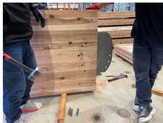
図 3 1 ドリフトピン打ち込み前の様子
