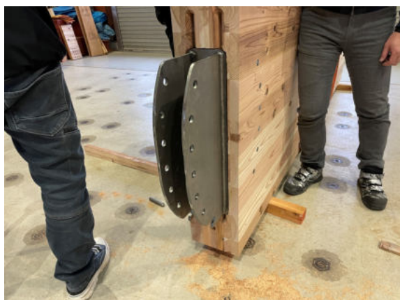
図 3 0 金物挿入時の様子
