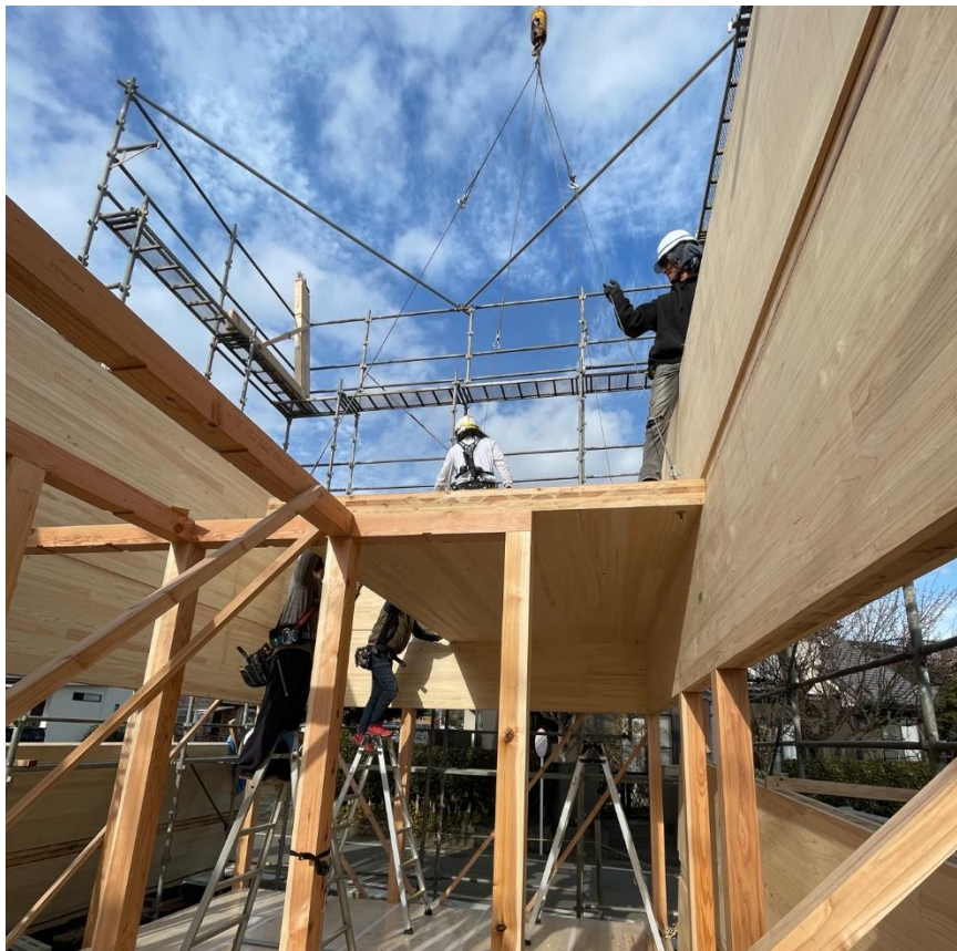
床パネルの施工状況 大入れ加工とすること で受け金物が不要と なる
