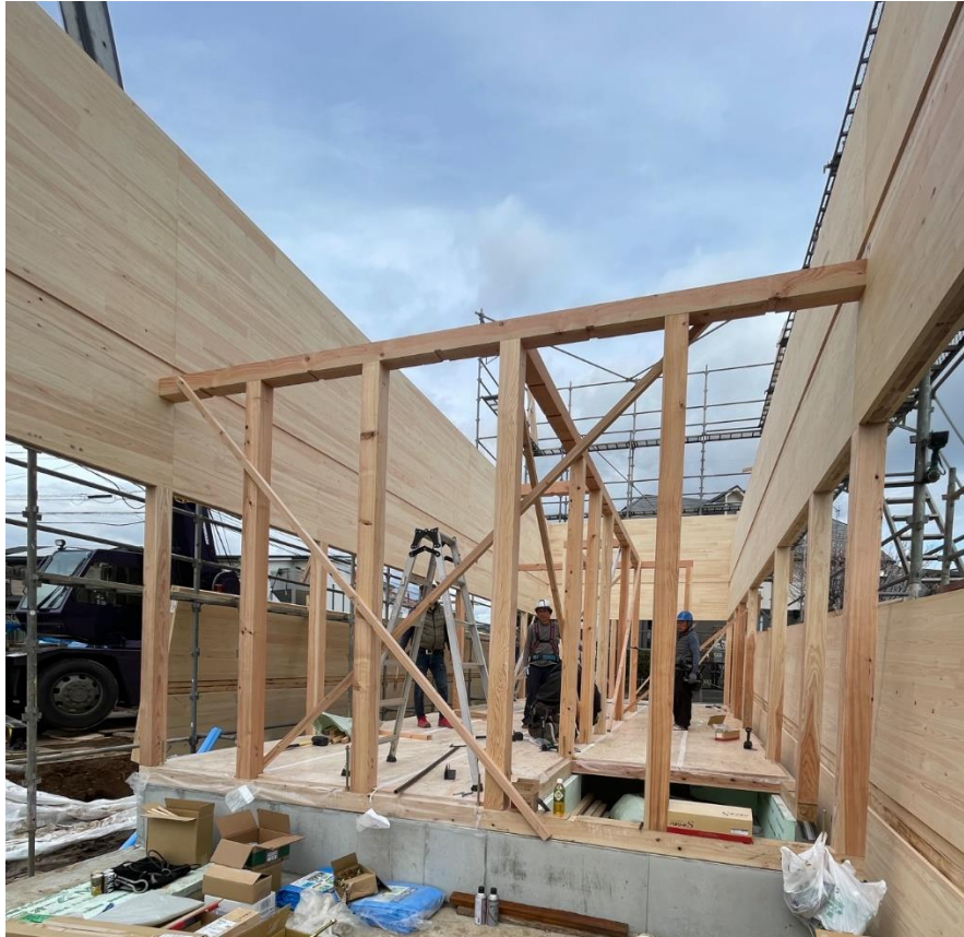
在来軸組み部と 大入れ加工の接合 状況
