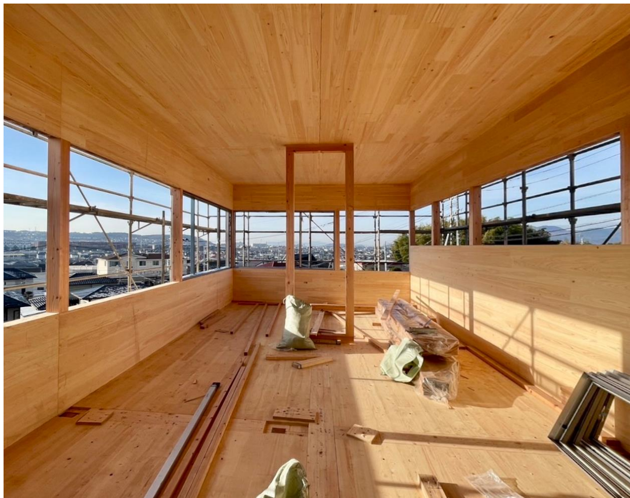
2階室内の建て方後。外周部はすべて開口となります。
