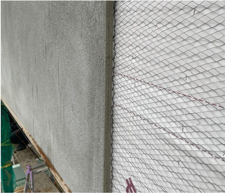
外部の断熱モルタル 施工状況
