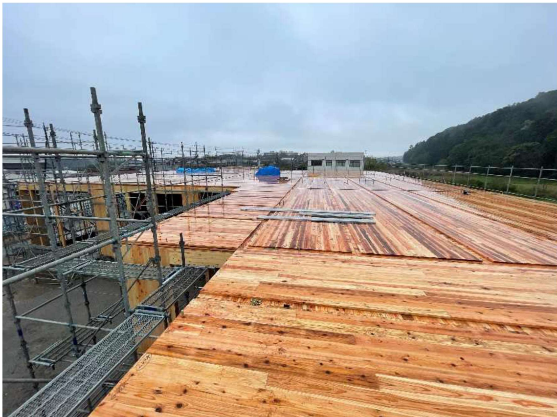
写真 3.3.6 外部建て方状況
