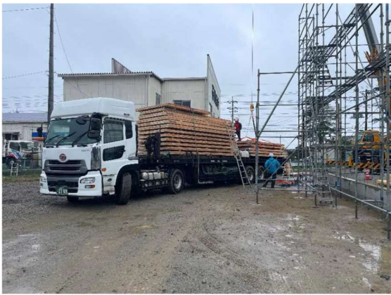
写真 3.2.1 軸材 搬入状況
