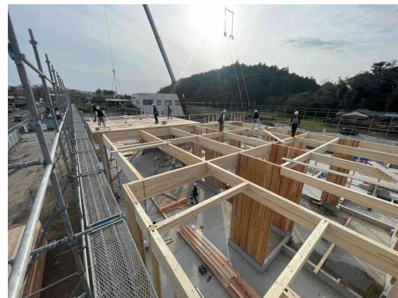
写真 3.3.4 大梁・小梁組み立て状況
