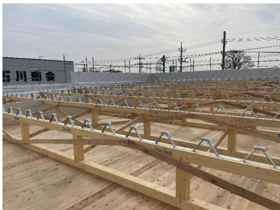
写真 3.4.3 タイトフレーム取り付け
