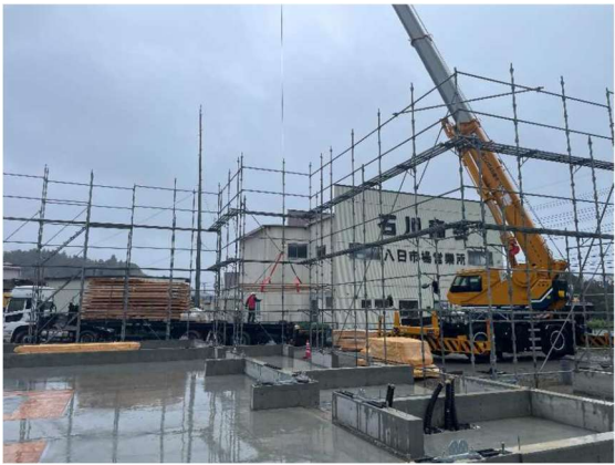
写真 3.2.2 軸材 荷下ろし状況
