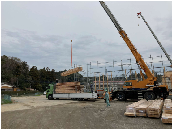
写真 3.2.4 床材 搬入状況
