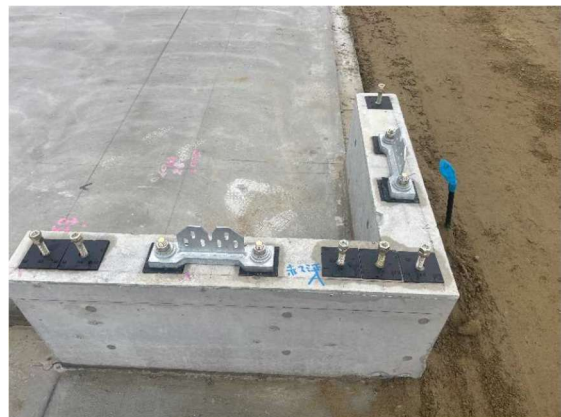
写真 2.2 せん断金物取付状況
