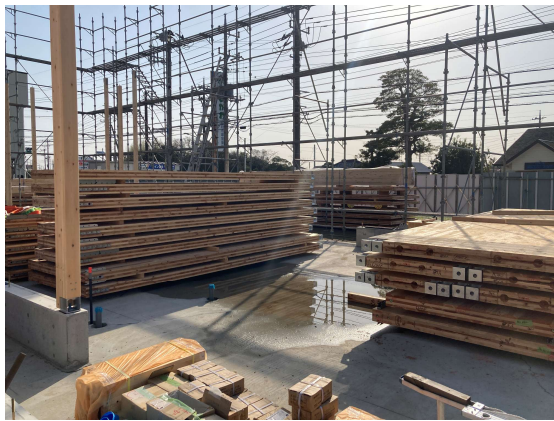
写真 3.3.1 壁パネル仮置き状況
