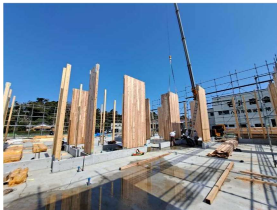
写真 3.3.3 CLT 壁パネル施工状況
