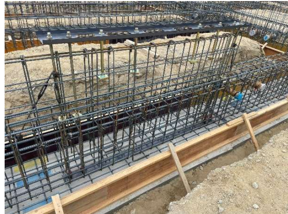
写真 1.2 アンカーボルト設置状況
