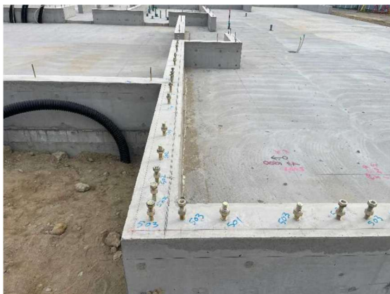
写真 2.1 基礎立上り 墨出し、高さ測定
