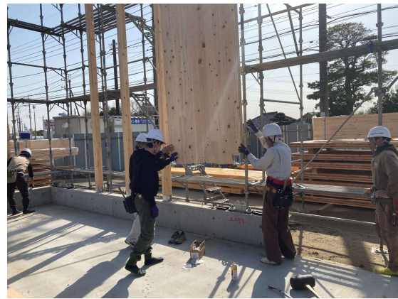
写真 3.3.2 CLT 壁パネル建て込み状況
