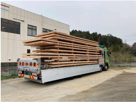
写真 3.2.3 床材 搬入状況
