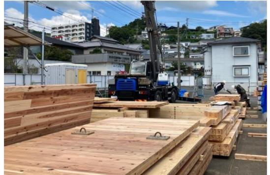
別府の工事に慣れた地元事業者のトラック運転手を手配し、2t ロングへCLT パネル専用架台を取り付け小運搬を行う
