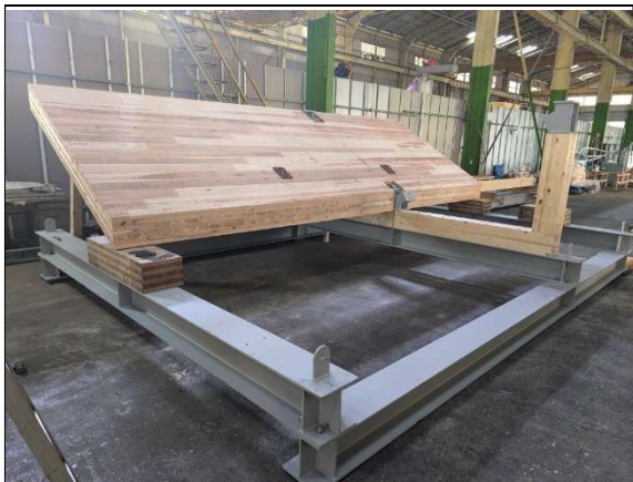
片側 CLT 設置
