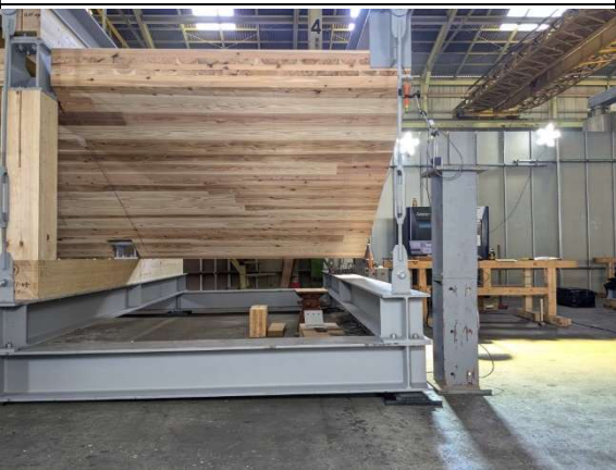
組立完了（側面）
