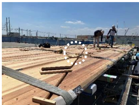
図-22 CLT敷きならべ時隙間調整治具
