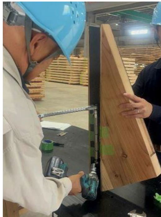
図-18 部分モックアップによる締め付け検証
