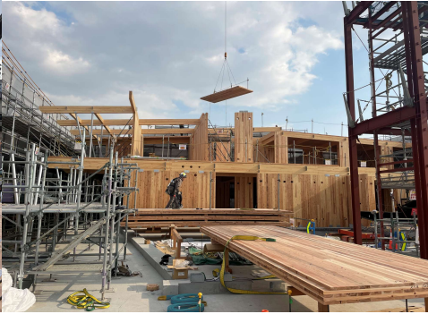
写真-13 CLT 建て方の様子 2
