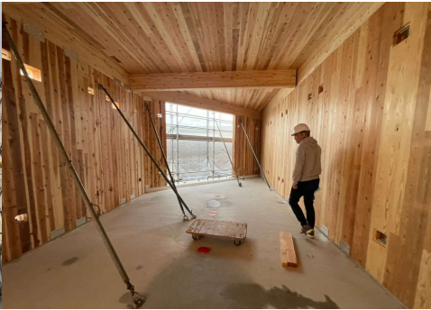
写真-15 別館内部の様子
