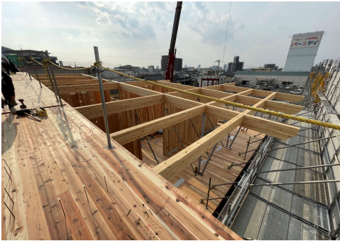
写真-14 R 階スラブ設置の様子
