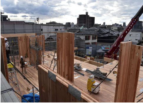
写真-12 CLT 建て方の様子 1
