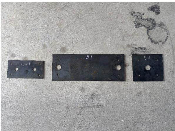
図 4.2-7 アンカーボルトセットテンプレート①
