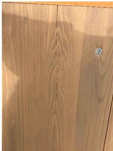
図 2.2-5 ひび割れ発生写真
