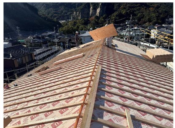
図 3.2-6 ⑥屋根断熱下地、ガルバ屋根葺き
