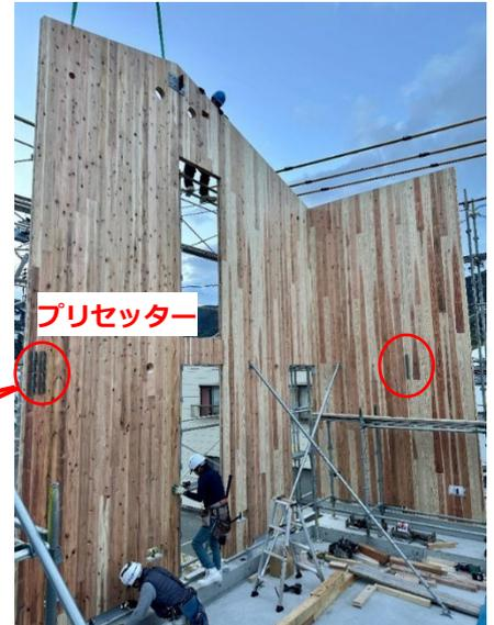
図 3.2-2 ②外壁 CLT2 層パネル取付
