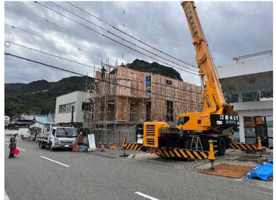
図 4.1-1 CLT 建て方施工写真
