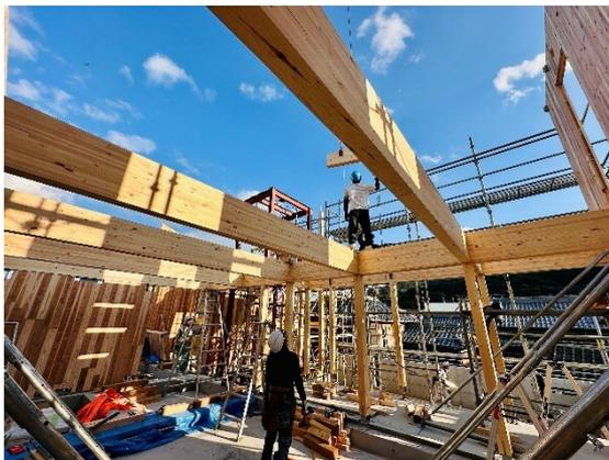
図 3.2-3 ③一般木造軸組完了時
