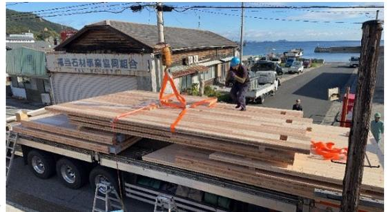
図 4.2-4 CLT 吊上げ作業
