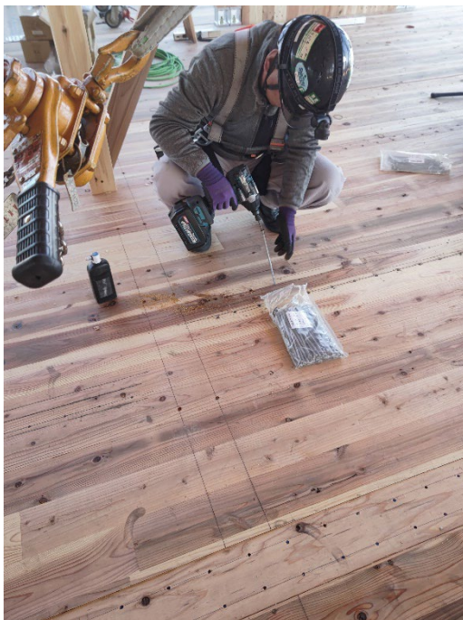
写真 4-1 長ビス施工状況
