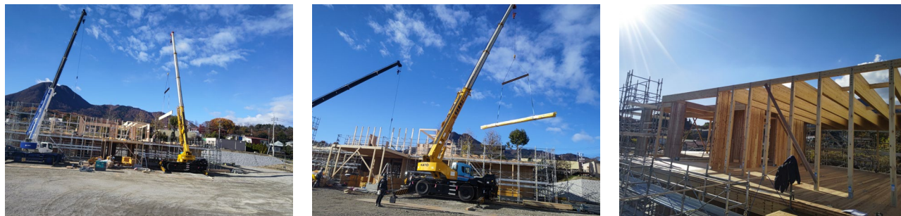
写真 5-4 2階壁・柱・梁 建込状況
