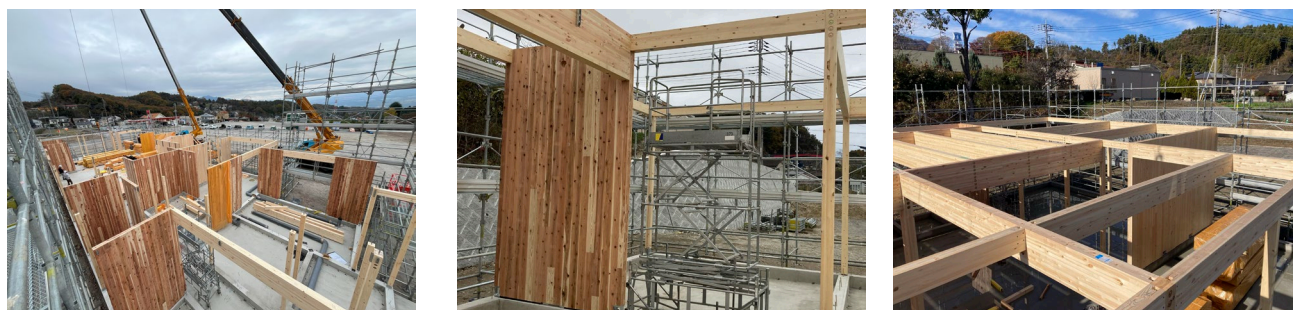
写真 5-2 1階壁・柱・梁 建込状況
