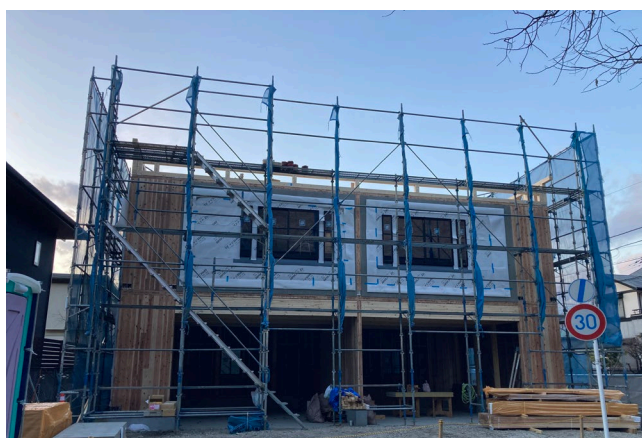
図 5-5 CLT パネル工法の建方完了(写真)
