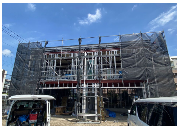
図 5-6 軽量鉄骨造の建方完了(写真)
