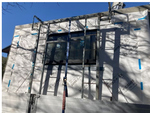
写真 1 サッシが組み込まれた非構造壁パネル
