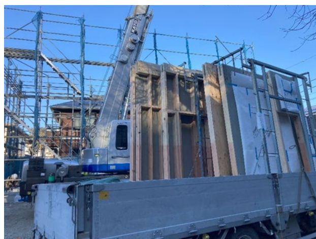
図 3-8 場搬入時専用ラックで積載された非構造壁パネル(写真)
