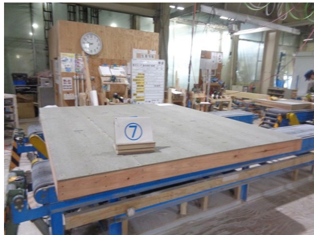
図 3-4 面材(硬質木片セメント板)施工後(写真)
