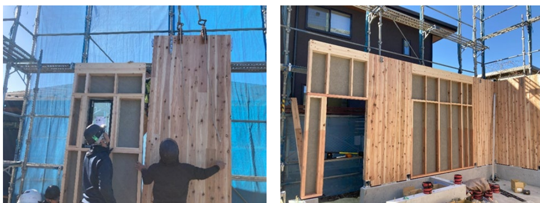
図 4 非構造壁パネルと CLT 耐力壁の施工状況(写真)
