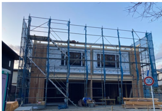
写真 2 CLT パネル工法の建方完了
