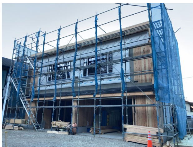
図 3-10 構造部分まで完了した状態(写真)
