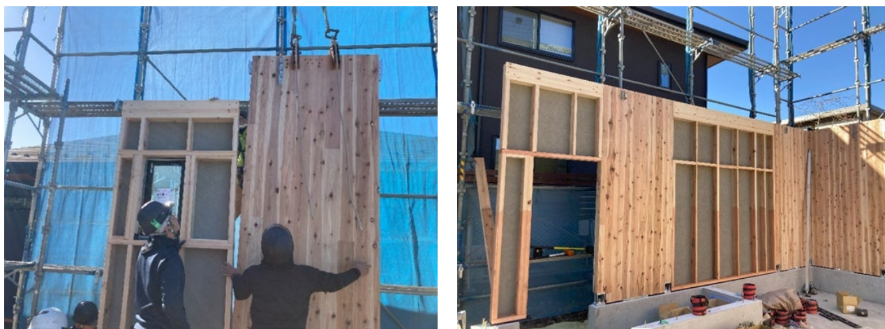
図 3-9 非構造壁パネルと CLT 耐力壁の施工状況(写真)
