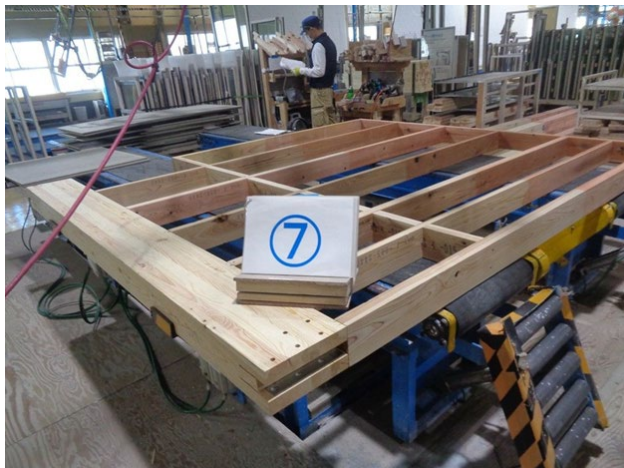
図 3-3 柱・梁・間柱を組上げ状態(写真)
