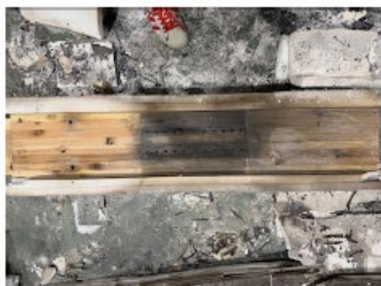
写真8 [下部] せん断金物解体後
