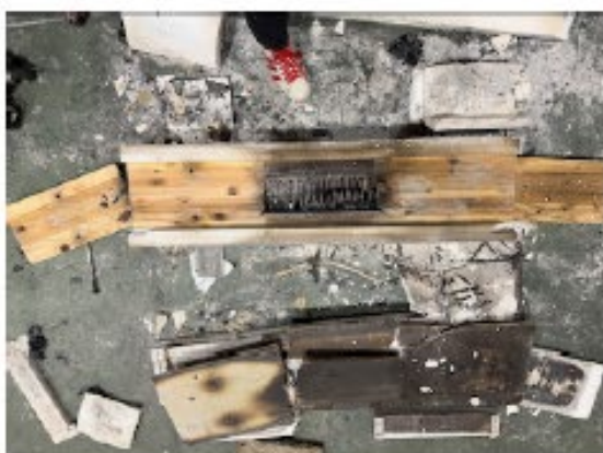
写真7 [下部] Jパネル解体後
