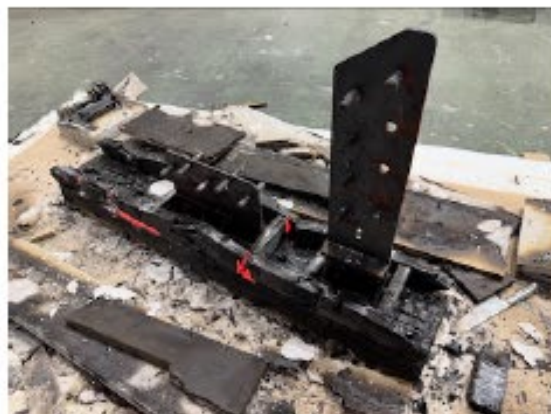
写真4 [上部] 被覆解体後の木部
