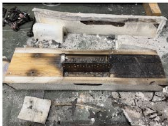
写真6 [下部] 被覆解体後の木部
