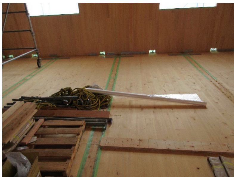
床 CLT パネル間雨養生
