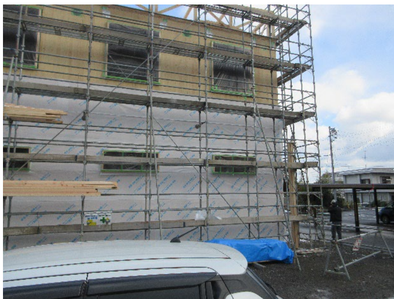
外張り透湿防水シート状況
