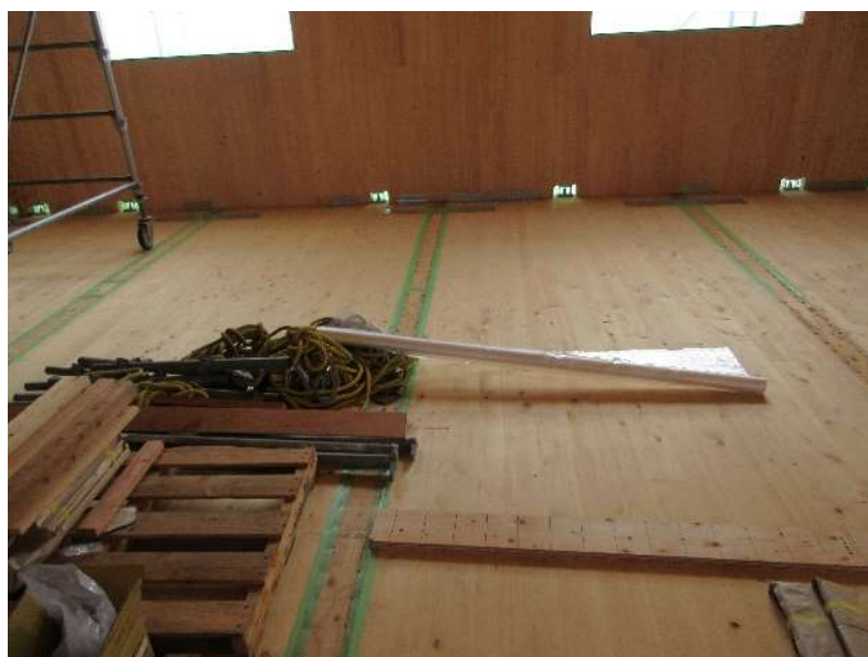
床 CLT パネル間雨養生
