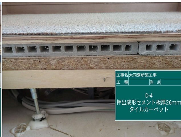
D-4 床施工断面写真
