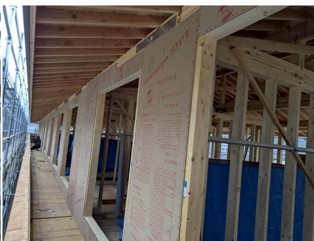
耐力壁面材の施工状況
