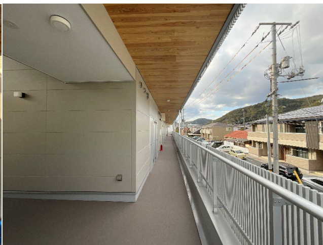
燃えしろ設計による CLT 軒裏現し仕上げ
