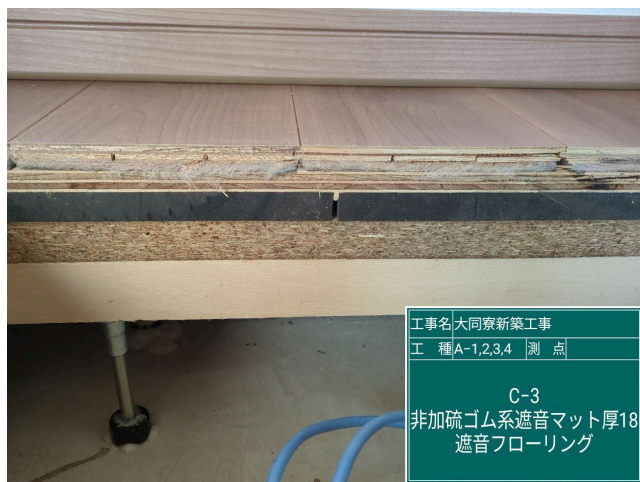
C-3 床施工断面写真
