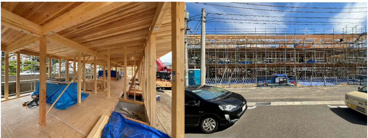
規格材で構成された1階軸組と2階CLT床の建方状況
