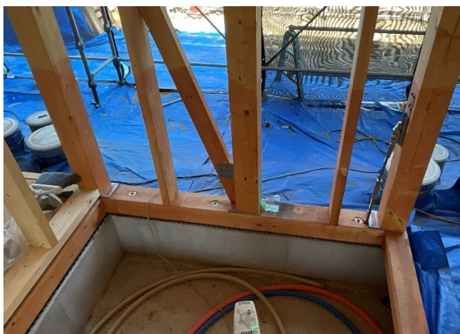
めり込み防止プレートとホールダウン接続ケーブル施工状況
