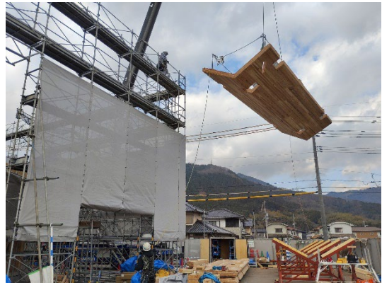
図 5.2 CLT 折板構造の地組
