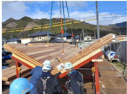
図 5.2 CLT 折板構造の地組
