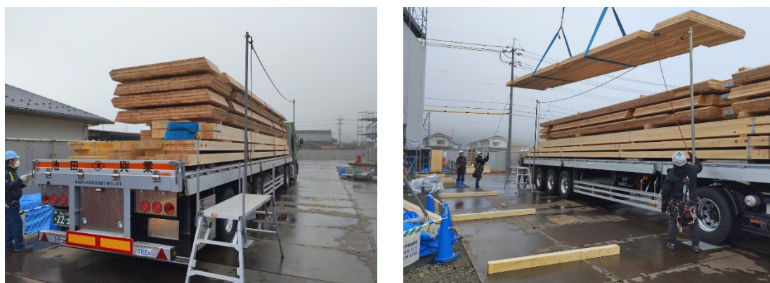
図 5.1 CLT の搬入
