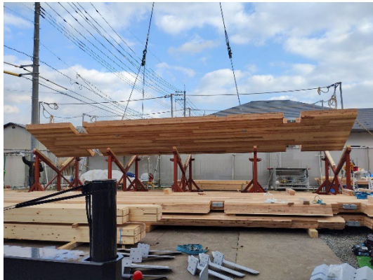
図 5.2 CLT 折板構造の地組
