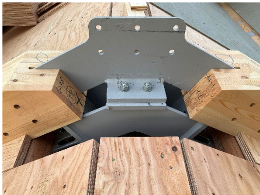
図 3.4 CLT 接合金物の施工状況
