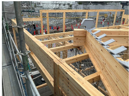
図 3.4 CLT 接合金物の施工状況
