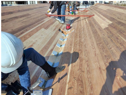
図 5.2 CLT 折板構造の地組
