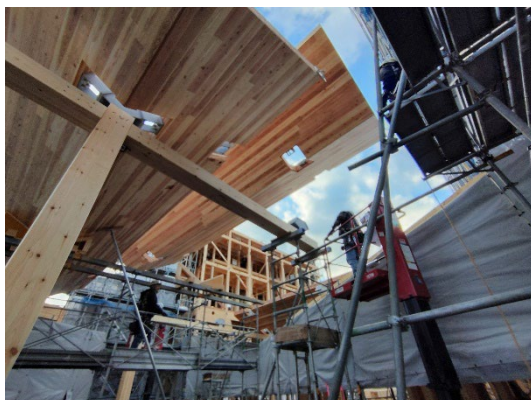
図 5.3 CLT 折板構造の揚重
