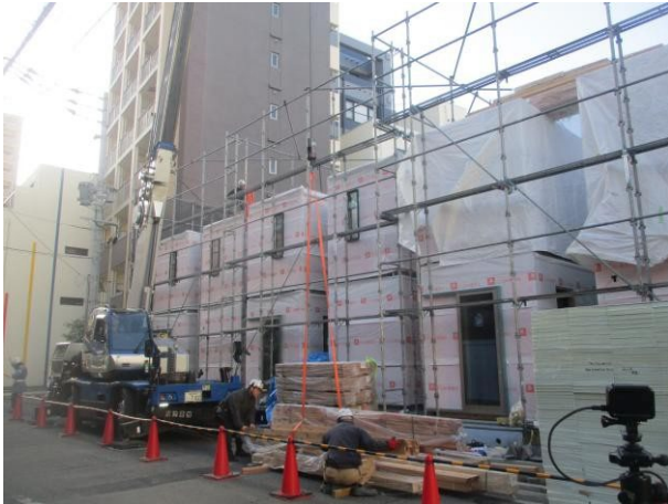
(写真③)CCU ユニット設置完了
