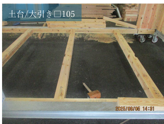
・Unit内の在来床組み構成
