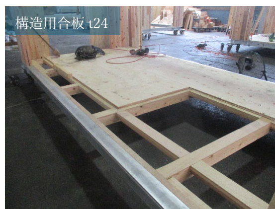
・構造用合板敷き込み
