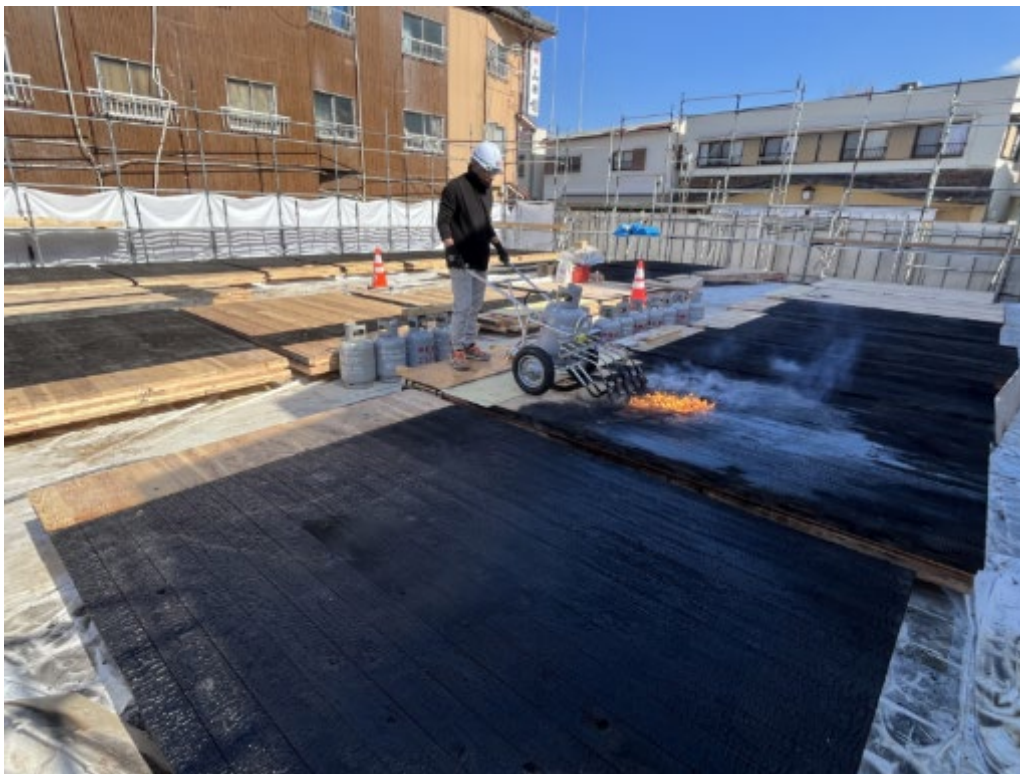
写真2)-4 焼焦がし施工風景
