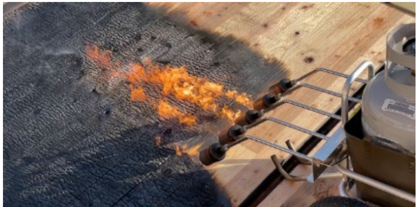
写真2)-1 CLTの焼焦がし
