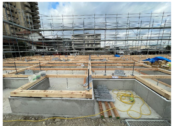
図 16 打設時および土台敷後の様子
