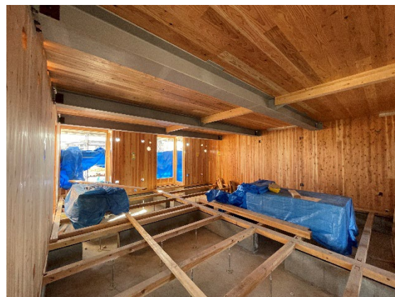
図 18 鉄骨梁を用いた共用スペース
