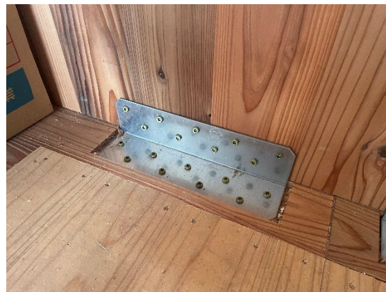
図 12 座彫り部への金物設置
