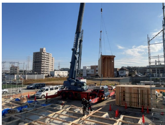
図 17 CLT ユニットの吊り込みと据え付け後の様子
