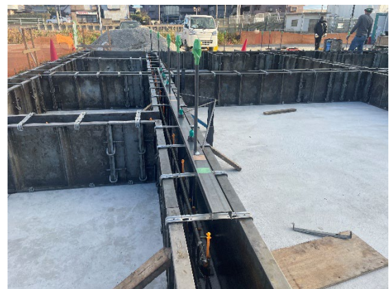
図 15 アンカーフレームの設置状況
