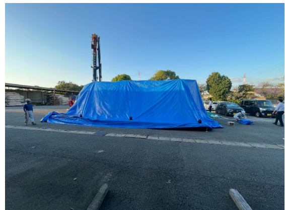
図 14 CLT ユニットの雨養生
