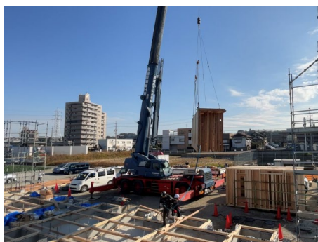
現場でのユニット吊り込み
