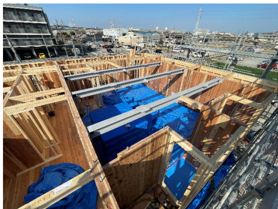
図 18 鉄骨梁を用いた共用スペース
