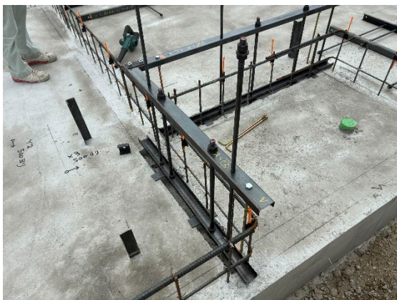
図 15 アンカーフレームの設置状況
