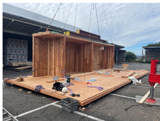
図 2 CLT ユニットのモックアップ
