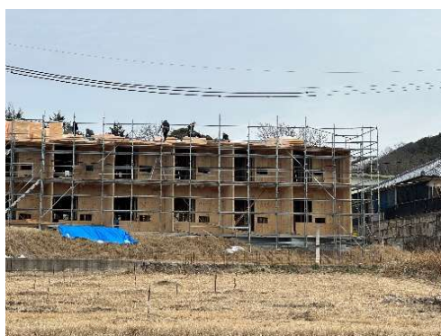
図 3.3-6 外壁下地施工状況
