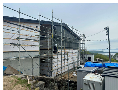
図 3.3-7 焼杉施工状況
