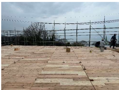
図 3.3-3 2 階床 CLT 施工完了
