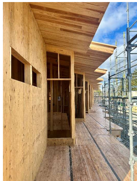
図 2.1-6 2 階共有廊下施工写真
