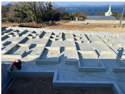
図 3.3-1 基礎施工完了
