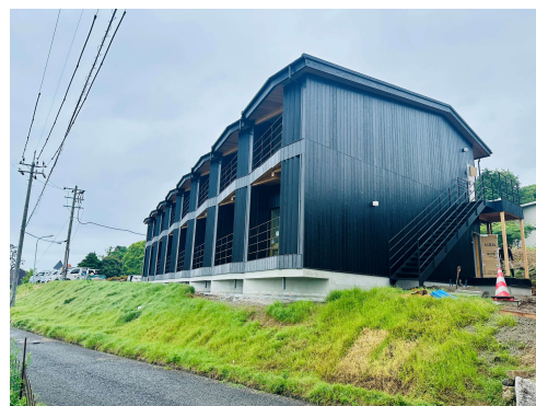
図 3.3-8 焼杉施工完了
