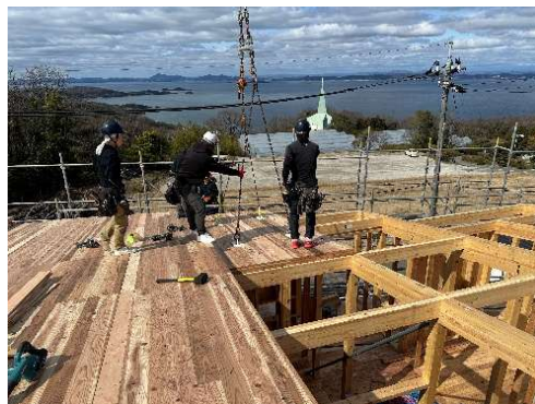
図 3.3-5 屋根 CLT 施工状況
