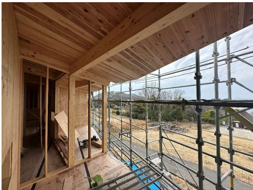
図 2.1-5 2 階バルコニー施工写真
