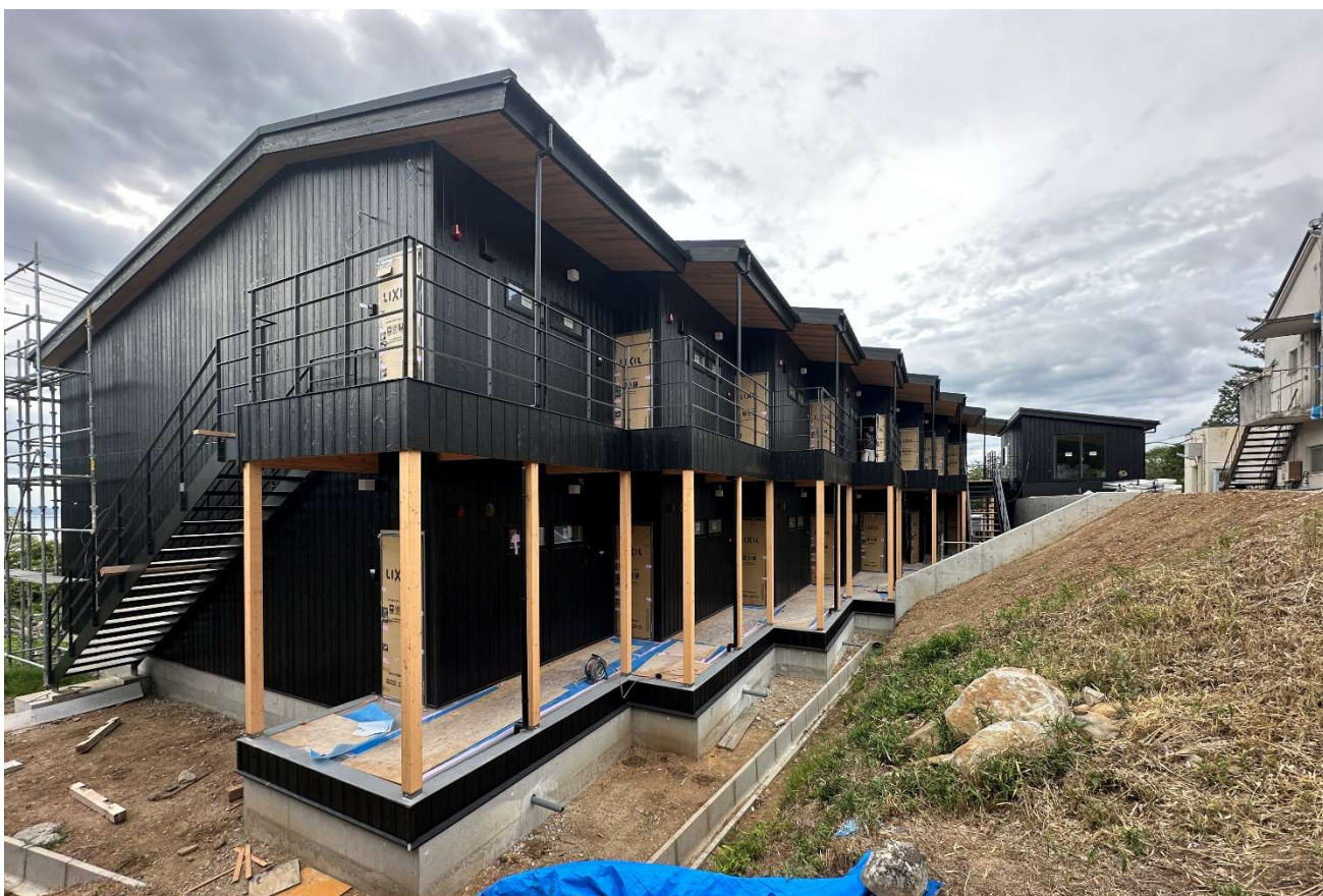
図 2.1-7 南東側施工写真
