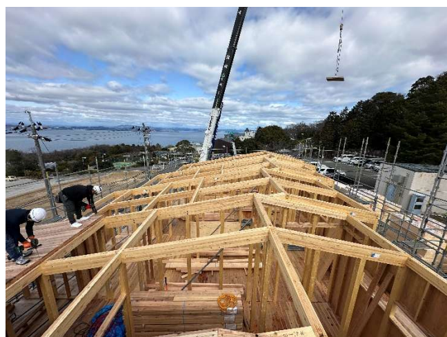
図 3.2-6 建て方完了状況
