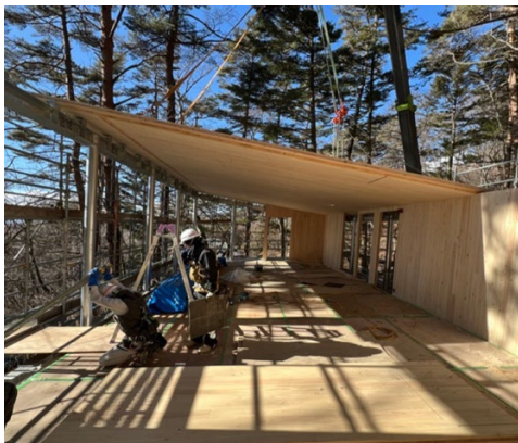
CLT+鉄骨の総合建方 Fig. 12.
