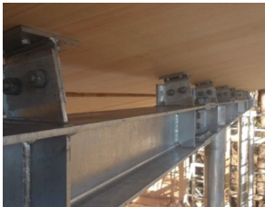
ファサード詳細 (CLT+鉄骨詳細 木質マリオン+ダイレクトイン) Fig. 8. 9. 10
