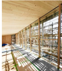
ファサード詳細 (CLT+鉄骨詳細 木質マリオン+ダイレクトイン) Fig. 8. 9. 10
