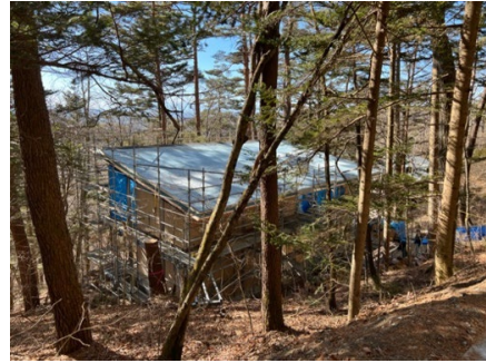
外観2 (屋根俯瞰) Fig. 7.
