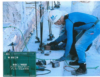
【工事種目】基礎工事 アンカー工事 【施工内容1】CLT棟基礎 アンカーセット状況
