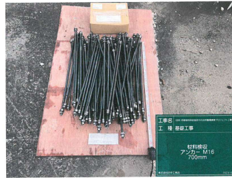
【工事種目】基礎工事 アンカー工事 【施工内容1】材料検取 アンカー M16 700mm
