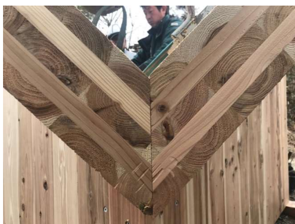
モックアップの組立精度 V 字梁
