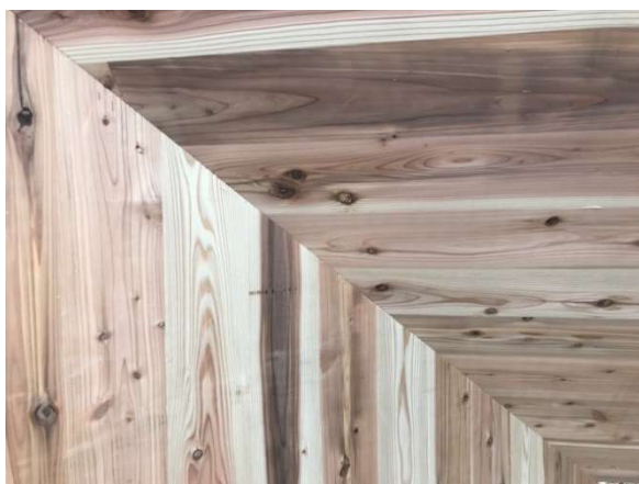
モックアップの組立精度 柱—梁接合部
