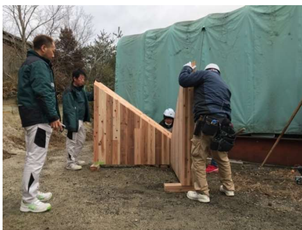
モックアップの組み立ての様子 V 字柱
